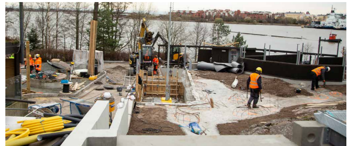
Saukko- ja vesikkotarhojen uudistaminen oli vuoden suurin rakennushanke.
